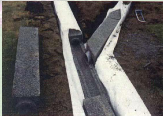
圖3-25 雨水滲透側溝實例
