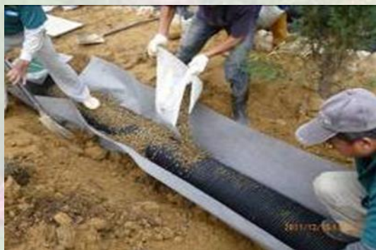
圖3-16 雨水滲透排水管實例
