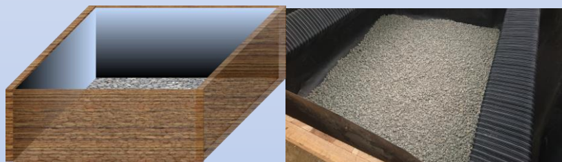
3. 不透水布 底部鋪設5cm碎石層
