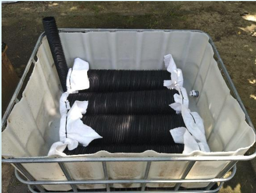
自主灌溉床容器擺設AMP-8"滲透網管
