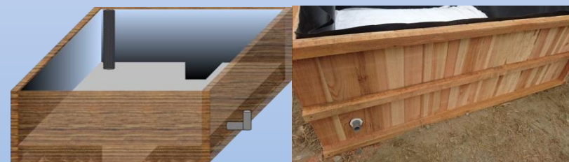
6. 安裝進水管及溢水管
