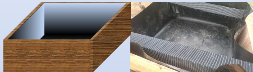
2. 護欄內鋪設不透水布
