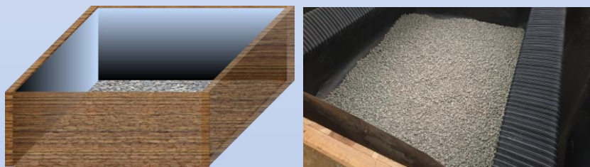
3. 不透水布 底部鋪設5cm碎石層
