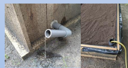
6. 安裝進水管及溢水管
