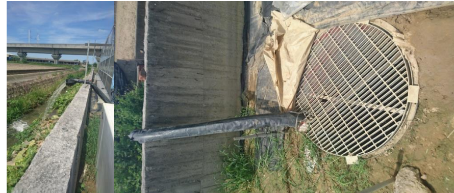
抽離地下水降低地下水位
