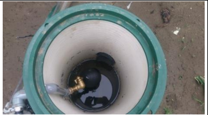
安裝水位控制閥
